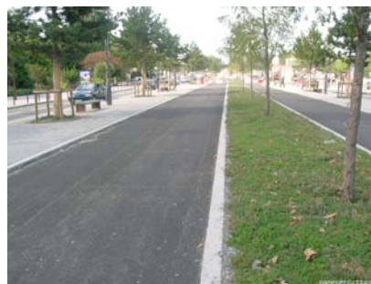
着々と工事が進められる BUSWAY (バス専用路線)
